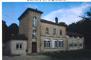
La Villasatel - centre d'hébergement
